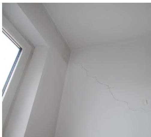
4.4.4.att. Konstatētas slīpas plaisas 3. stāvā, telpā Nr. 57 pēc inventarizācijas lietas, iespējams plaisas saistītas ar grīdas konstrukcijas sēšanos, jo siena uzmūrēta uz grīdas slāņiem. Apskatot šo pašu vietu citos ēkas stāvos sienas ir bez plaisām.
