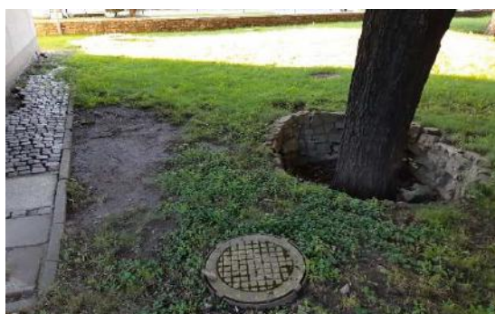
3.4.3.att. Mūra apdobe ap koku izdrupusi, taču noturību pagaidām saglabā. Bruģētā ēkas apmale izrobota, daļēji aizaugusi ar zāli un vietām bruģa segums aizstāts ar betona plāksnēm.
