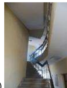
4.10.3.att. Saliekamā dzelzsbetona kāpnes no laidiem un laukumiem. Pakāpienu virsma nosepta ar plastmasas apdares materiālu.
