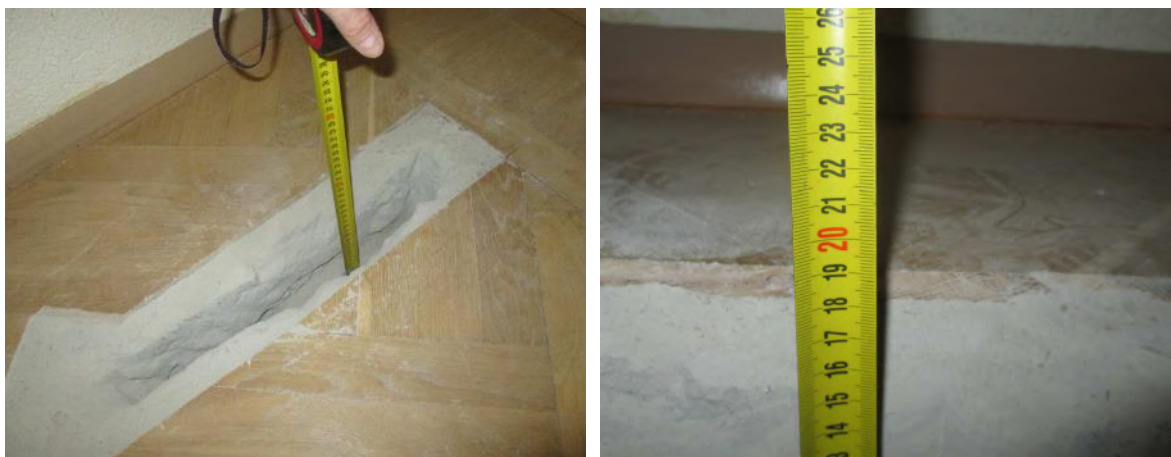
4.12.2.att. Grīdas atsegums 1.stāvā telpā Nr. 16.
