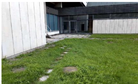
3.1.6.att. Ietve ar betona plātņu segumu ēkas D spārna R pusē gandrīz pilnībā pazudusi zālē.
