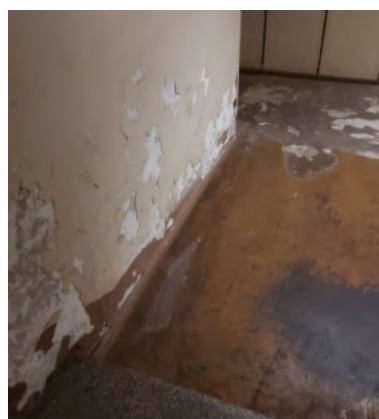
4.1.6. att. Pagrabā mitruma ietekmē atdalās sienu krāsojums un apmetums
