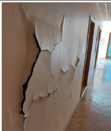
4.4.1.att. Apmetuma atdalīšanās no sienas 2.stāva dienvidu spārnā.
