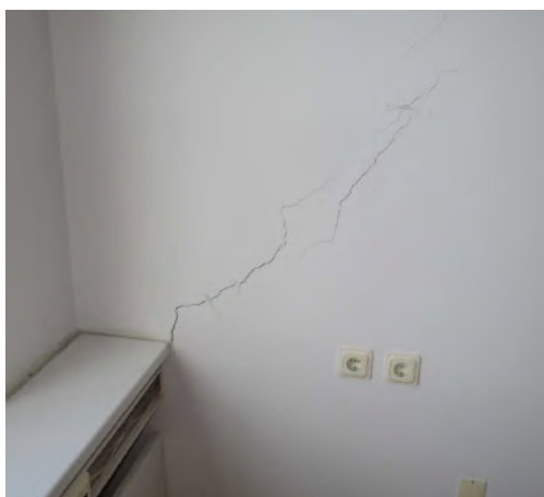
4.4.4.att. Konstatētas slīpas plaisas 3. stāvā, telpā Nr. 57 pēc inventarizācijas lietas, iespējams plaisas saistītas ar grīdas konstrukcijas sēšanos, jo siena uzmūrēta uz grīdas slāņiem. Apskatot šo pašu vietu citos ēkas stāvos sienas ir bez plaisām.
