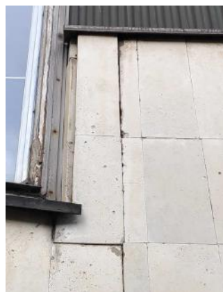
4.19.3.att. Pie centrālās kāpņu telpas logiem atdalās dolomīta plāksnes.
