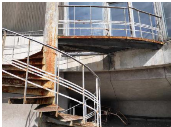
4.10.16.att. Kāpnēm konstatēta būtiska tērauda korozija, bet tās ir apmierinošā tehniskā stāvoklī.
