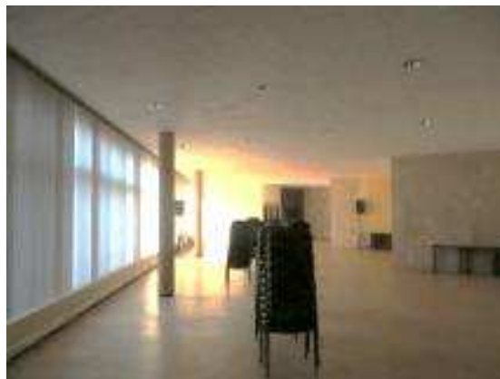
4.3.9.att. 1.stāva konferenču zāles apaļās dzelzsbetona kolonnas.
