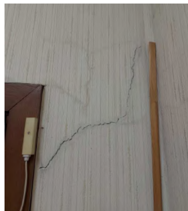
4.11.3.att. Konstatētas plaisas ķieģeļu mūra nenesošās starpsienās 1.stāvā telpā Nr. 6 Sienas neapmierinošā stāvoklī.
