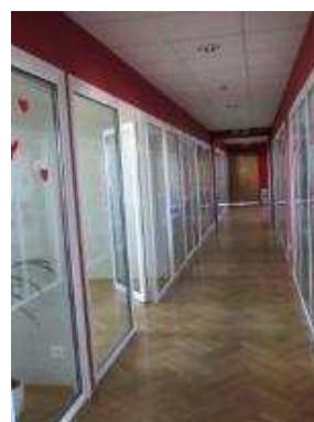
4.11.7.att. PVC karkasa stiklotas starpsienas 6.stāvā, labā tehniskā stāvoklī.
