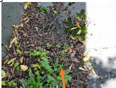
4.8.5.att. Siltummezgla jumts, daļa no jumta veidota kā zaļais jumts, bet daļa ir apaugusi ar sūnām.
