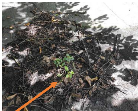
4.8.6.att. Garāžu jumts ir būtiski apaudzis ar sūnām un zāli.
