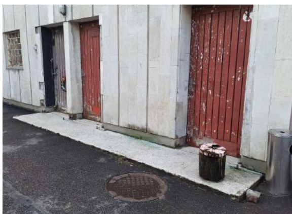
4.10.19.att. Ēkai izbūvēts panduss pie ieejām telpās Nr. 63, 64, 75. Apmierinošā stāvoklī.
