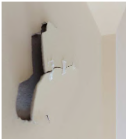
4.4.5.att. Apmetuma atdalīšanās no sienas 4.stāva telpā.
