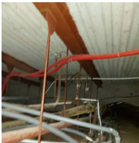
4.6.1.att. 1.stāva pārsegums izbūvēts no tērauda dubult-T sijām uz kurām balstās monolītā dzelzsbetona plātne.
