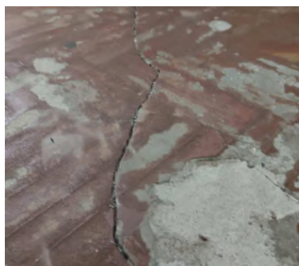
4.12.14.att. 1.stāvā telpā Nr. 33 mitruma ietekmē bojāts grīdas segums, kā arī konstatēta plaisa grīdā ar platumu 0,5-1,5 cm.
