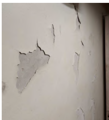
4.1.5. att. Pagrabā mitruma ietekmē atdalās sienu krāsojums un apmetums
