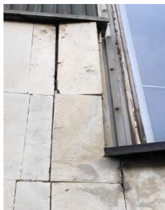
4.19.3.att. Pie centrālās kāpņu telpas logiem atdalās dolomīta plāksnes.
