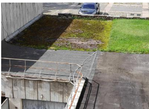
4.8.5.att. Siltummezgla jumts, daļa no jumta veidota kā zaļais jumts, bet daļa ir apaugusi ar sūnām.
