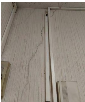
4.11.3.att. Konstatētas plaisas ķieģeļu mūra nenesošās starpsienās 1.stāvā telpā Nr. 6 Sienas neapmierinošā stāvoklī.
