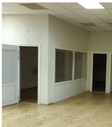
4.11.1.att. Ģipškartona nenesošās starpsienas 1.stāvā telpā Nr. 16. Sienas labā stāvoklī.
