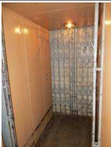
5.12.3.att. Kafejnīcas palīgtelpās atrodas kravās lifts ar celjspēju 1000 kg.
