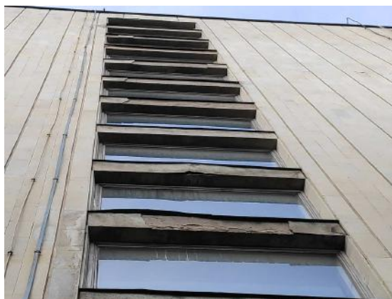
4.2.4. att. Dienvidu spārna galā esošās kāpņu telpas logu ailu pārsedzēm konstatēta apmetuma atdalīšanās Pārsedzes apmierinošā tehniskā stāvoklī, bet jāveic to atjaunošanas remonts.
