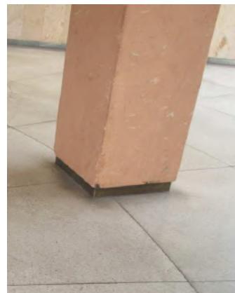
4.3.5.att. Ēkas centrālajā daļā, pie apaļajām kāpnēm, kolonnas 50x50cm apšūtas ar marmora plāksnēm.
