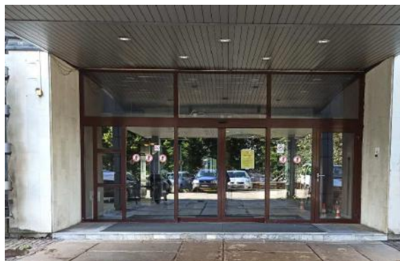
4.13.2.att. Galvenajai ieejai izbūvētas ārdurvis no PVC konstrukcijas, apmierinošā stāvoklī.
