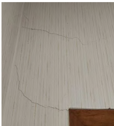
4.11.3.att. Konstatētas plaisas ķieģeļu mūra nenesošās starpsienās 1.stāvā telpā Nr. 6 Sienas neapmierinošā stāvoklī.
