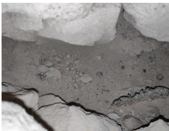
4.12.10.att. Grīdas atsegums 7.stāva telpas Nr.17 stūrī.
