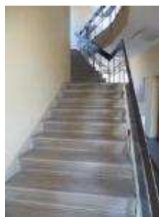
4.10.3.att. Saliekamā dzelzsbetona kāpnes no laidiem un laukumiem. Pakāpienu virsma nosepta ar plastmasas apdares materiālu.
