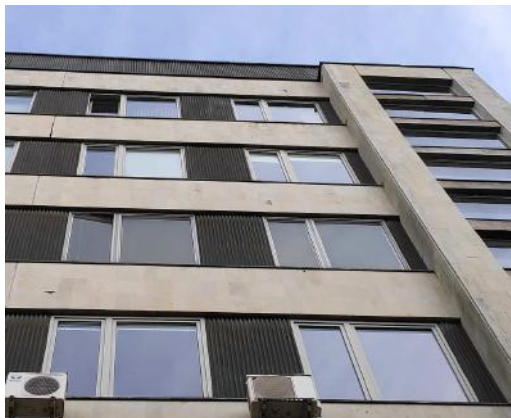
4.19.7.att. Vairākās vietās fasādes plāksnes izdrupušas un no tām atdalījušies dolomīta gabali. Fasādes plāksnes pie sienu paneļiem stiprinātas ar javu. Javas sasaistes resurss un nolietojuma pakāpe tuvojas maksimumam.
