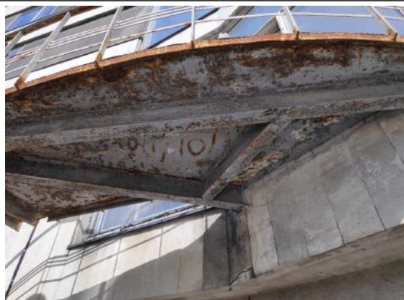
4.10.18.att. Vītņveida kāpņu pieslēgums ēkai.
