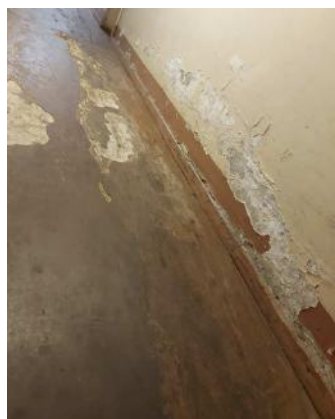
4.1.4. att. Pagrabā konstatēta mitruma ietekmē bojāta siena.
