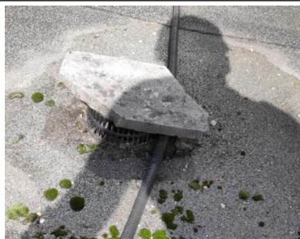
4.8.9.att. Kabelis uz jumta piespiests ar akmeni
