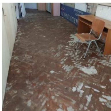
4.12.14.att. 1.stāvā telpā Nr. 33 mitruma ietekmē bojāts grīdas segums, kā arī konstatēta plaisa grīdā ar platumu 0,5-1,5 cm.
