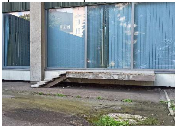
4.10.14.att. Ārējas kāpnes pie telpas Nr. 45 bez durvīm uz telpu. Kāpnes agrāk tika lietotas kā ieeja ēkā, bet laika gaitā šajā vietā demontētas durvis un izbūvēta stikla vitrīna. Apmierinošā stāvoklī, bet ja kāpnes plānots izmantot nākotnē ir jāveic to atjaunošanas remonts.
