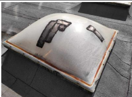
4.8.3.att. 1.stāva jumtam labotas virsgaismas.
