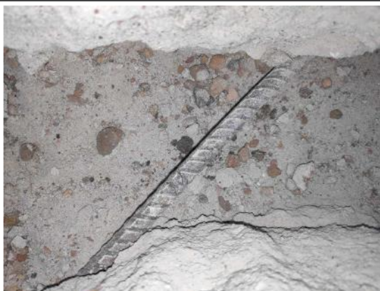
4.12.9.att. Grīdas atsegums 6.stāva telpā Nr.9.
